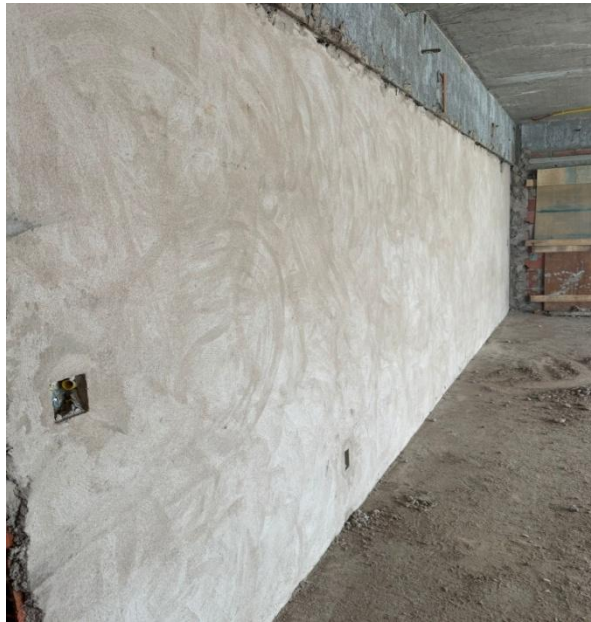
Figura 9 : Reboco ( Revestimento de parede)
