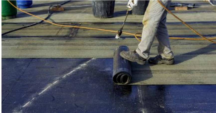
Figura 3 : Aplicação Manta
