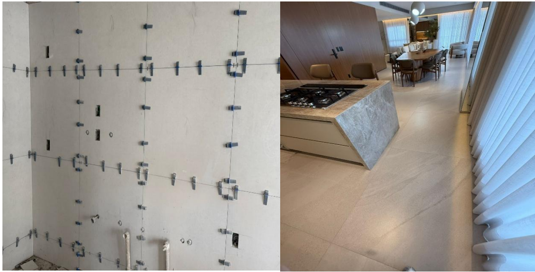
Figura 11 : Revestimento e Piso em Porcelanato
