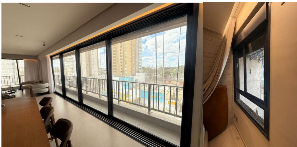
Figura 12 : Esquadrias de Alumínio
