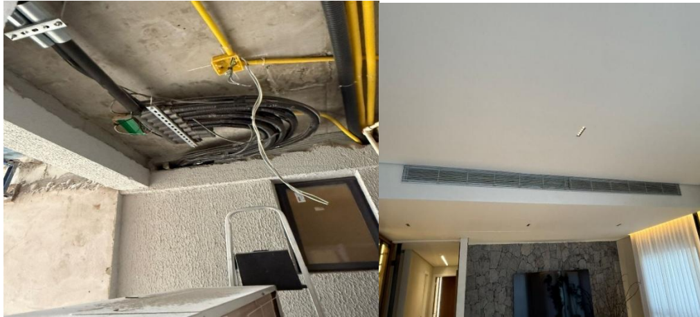
Figura 7 : Instalações Frigorígenas
