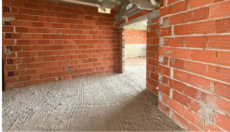
Figura 2: Alvenaria de Vedação
