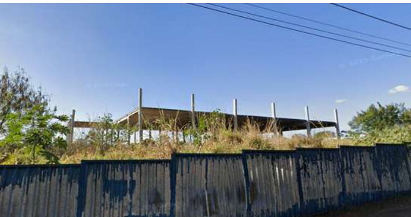
Figura 22: Edificações existentes no lote
