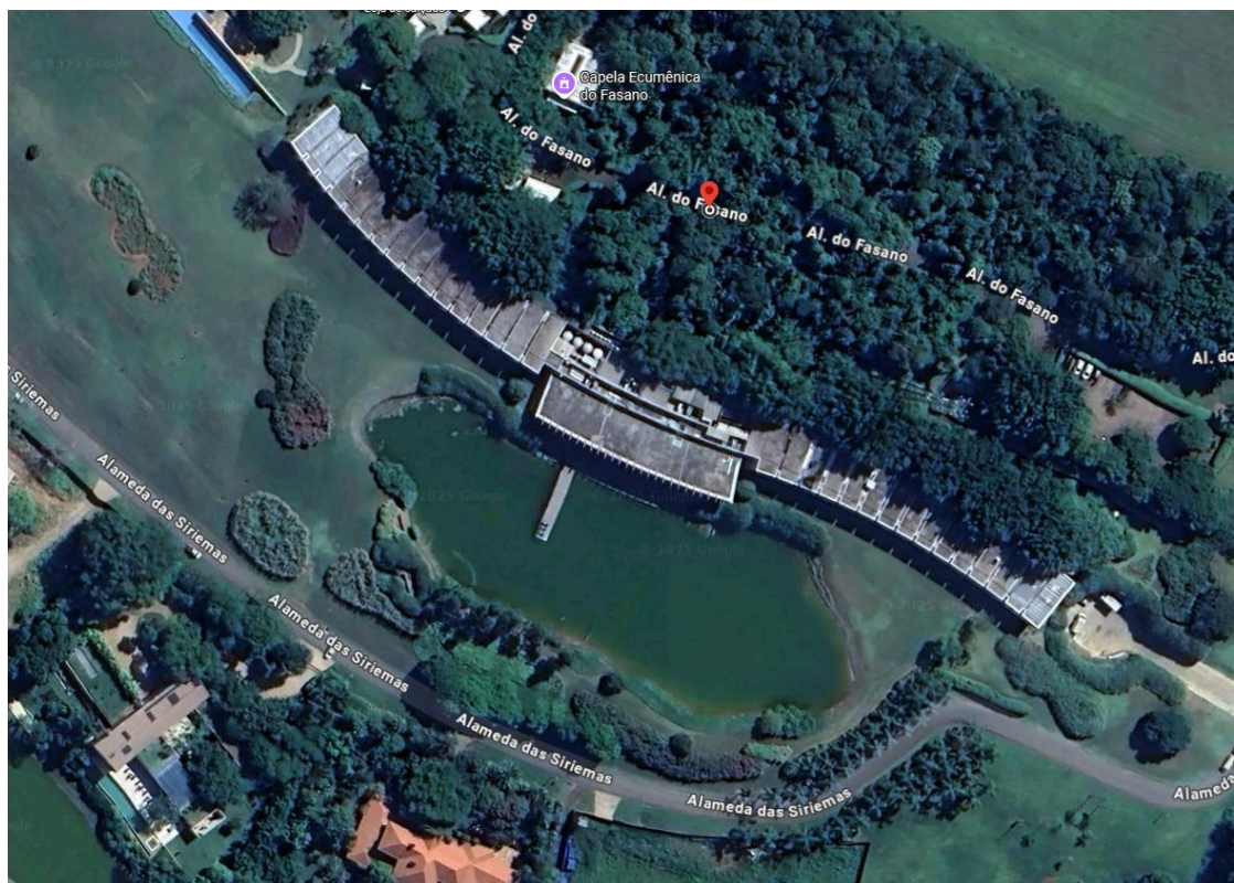
Figura 68: Fazenda Boa Vista – Vista da cobertura e forma da construção.
