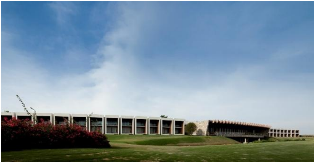
Figura 65: Foto do Hotel. https://www.isayweinfeld.com/arquitetura/hoteis-e-resorts/fazenda-boja-vista-hotel-fasano/
