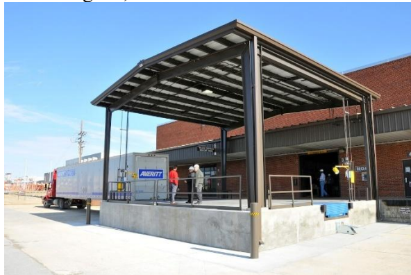
Figura 39: Docas / recebimento e armazenamento. Fonte: Pngtree, 2026.
