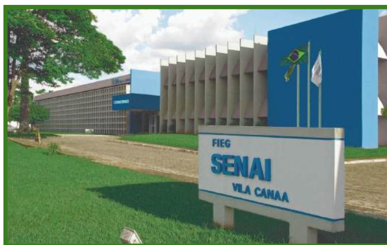
Figura 20: SENAI Vila Canaã (Antes da modernização)
