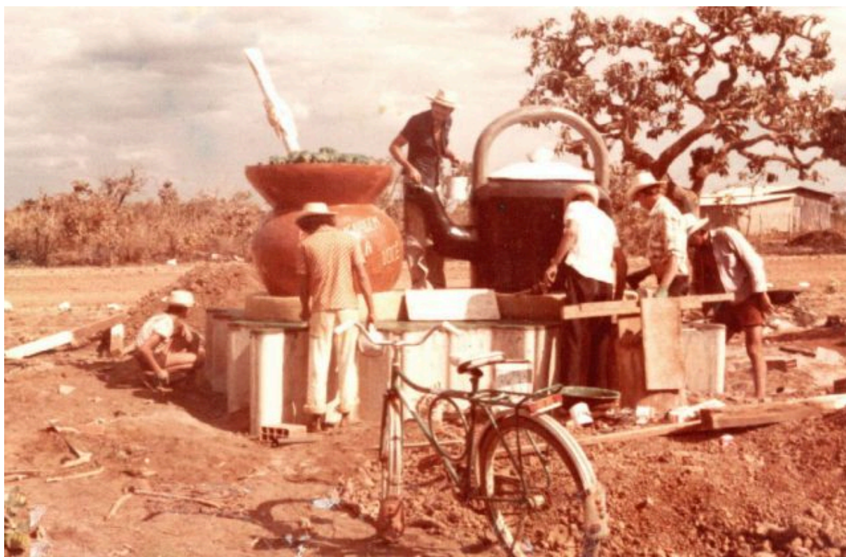
Imagem 1 - Construção do Monumento da Cuia e Chaleira
