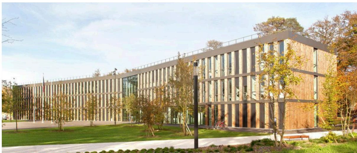
Fachadas do edifício administrativo e esportivo.
