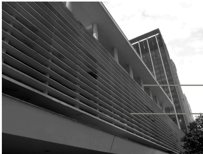
COLONAS DE CONCRETO ARMADO
