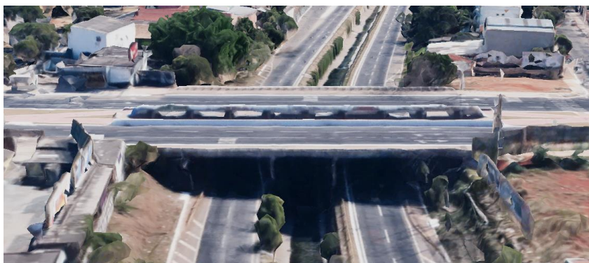
Figura 1: Vista Aérea da Ponte da Avenida Universitária sobre o Córrego Botafogo [6].
