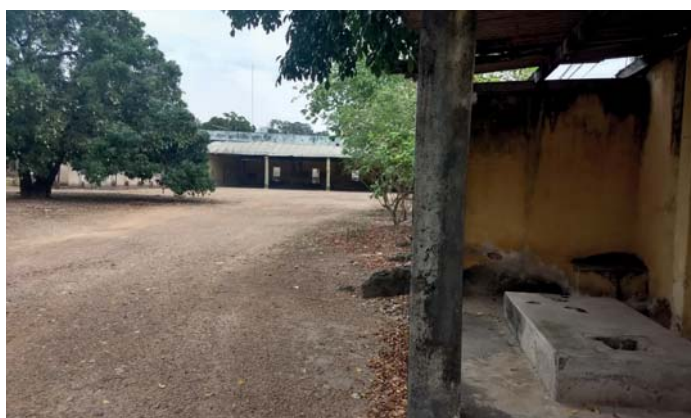
VISTA B: INTERIOR GALPÃO DA EMPRESA
