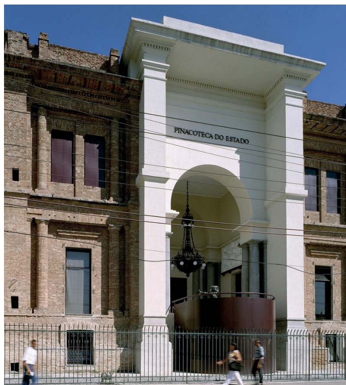
Imagem 20: Diversos tipos de intervenção em uma fachada.
