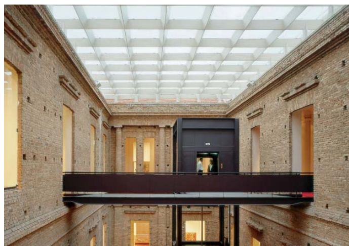
Imagem 19: Intervenção feita em aço.
