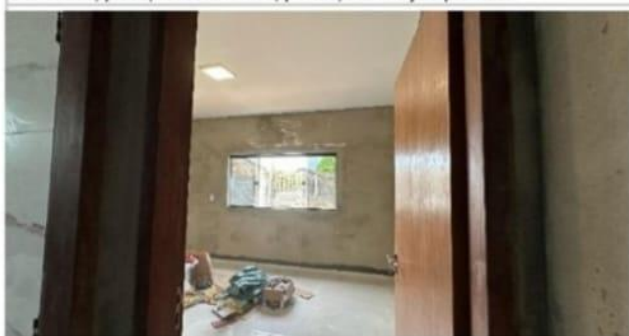
Bancadas, pisos, revestimentos, portas, iluminação prontas.
