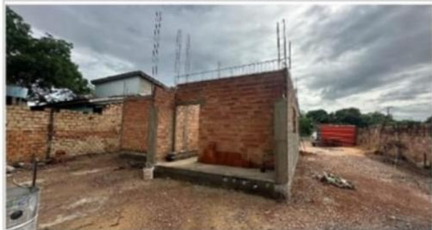
Fachada posterior - vigas de respaldo 50% concretadas e desenformadas
