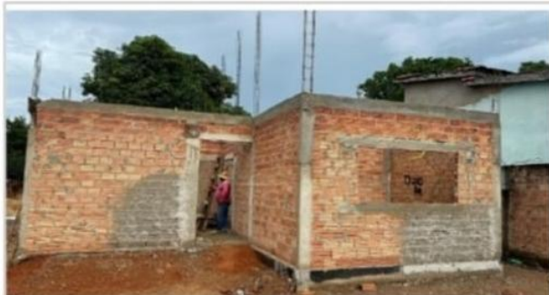
Fachada frontal - vigas de respaldo concretadas e desenformadas
