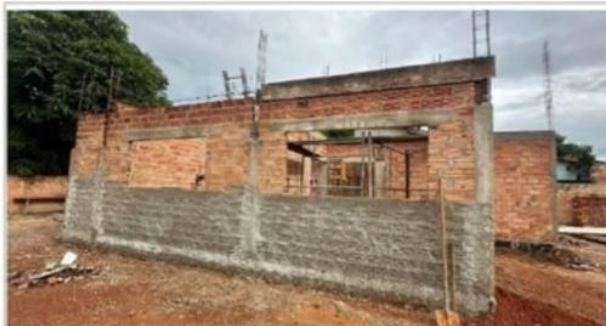
Fachada lateral esquerda - vigas de respaldo 50 % concretadas
