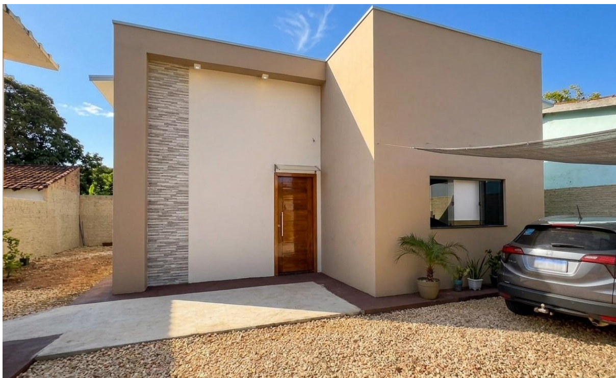
Figura 1- Fachada da residência unifamiliar
