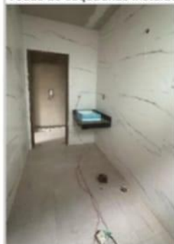
Bancadas, pisos, revestimentos, portas, iluminação prontas.
