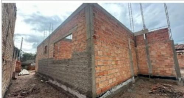
Fachada lateral direita - vigas de respaldo concretadas e desenformadas
