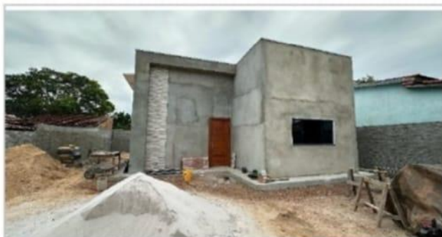
Todas as esquadrias instaladas e acabamentos.
