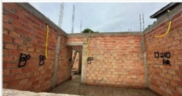
Vigas de respaldo internas concretadas e desenformadas.
