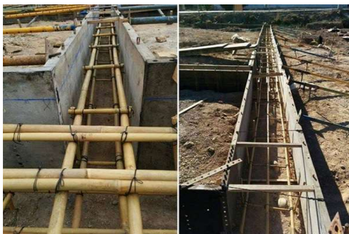
Figura 5 – Concreto Armado com Bambu (Bambucreto) [19]
