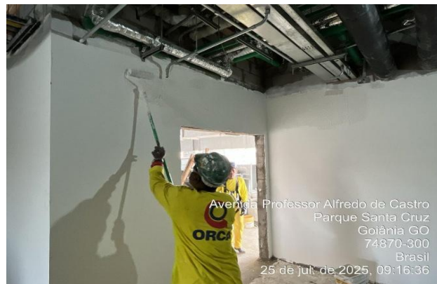
Figura 19 – Pintura da chapa de Drywall com rolo Fonte: Própria
