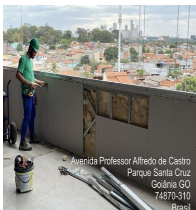
Figura 8 – Fixação da 1ª chapa da fachada
