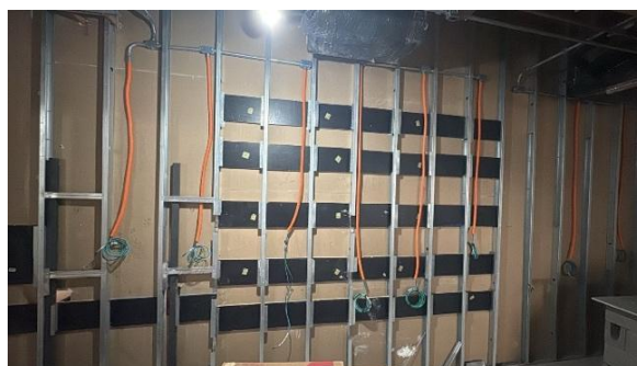
Figura 14 – Execução dos reforços de madeira Fonte: Própria
