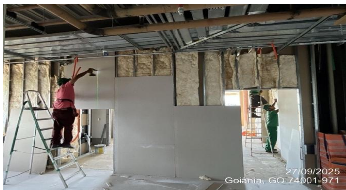
Figura 16 – Fechamento da 2ª chapa de Drywall Fonte: Própria
