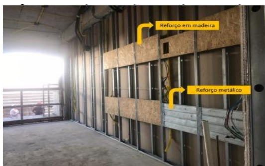
Figura 13 – Tipos de reforços Fonte: Carvalho (2022)
