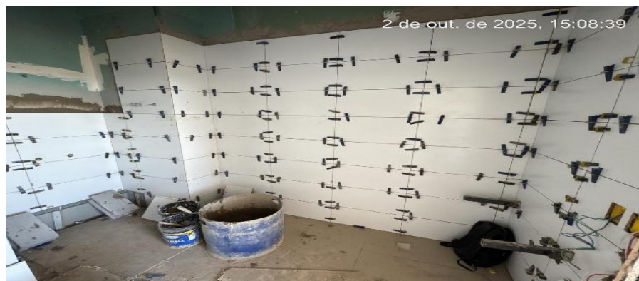
Figura 20 – Revestimento cerâmico do banho sobre chapa RU Fonte: Própria
