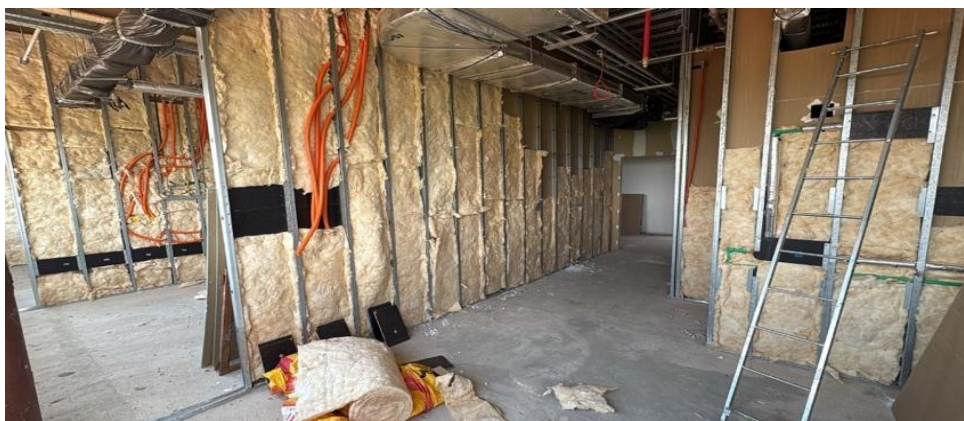
Figura 15 – Isolamento Termoacústico utilizando lã mineral Fonte: Própria
