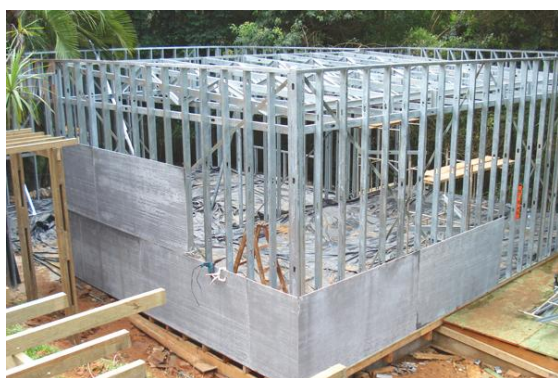
Figura 1 - Casa feita em estrutura de Light Steel Frame com placas cimentícia externa. Fonte: Contramarco, 2022
