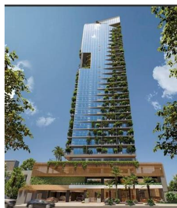
Figura 5 – Fachada Edifício B [19].
