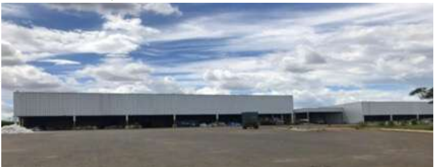
Fachada COPEL / Fonte: Autor.
