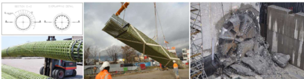
Figura 03: O uso de elementos de reforço de PRFV e o método de escavação mecanizada
