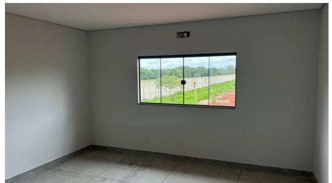
Figura 08 –Face Interna do Ambiente.
