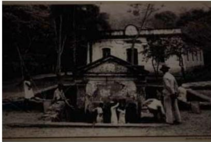
Figura 18: Vista da fonte da carioca e de carregadeiras de água século XIX
