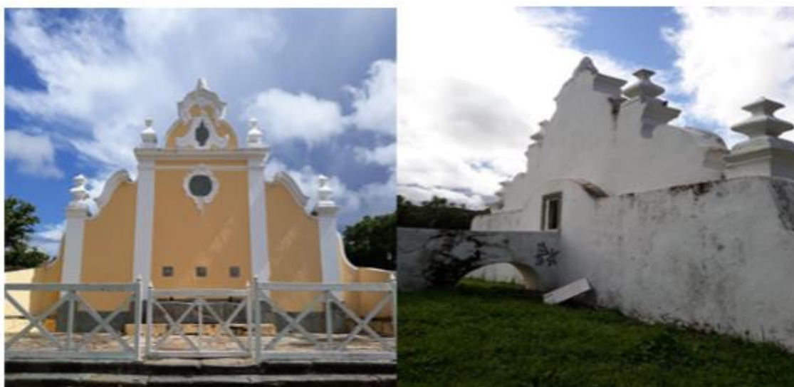
Figura 14. Vista do Chafariz de Calda da Praça Brasil Ramos Caiado
