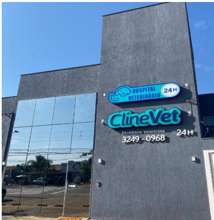
Figura 1 – Imagem da fachada do Hospital veterinário Mundo Animal – Clinevet (Goiânia - GO), em setembro de 2025.
