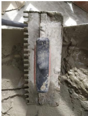
(e) Desempenadeira com dois dentes danificados
