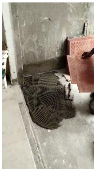
(a) Falta de limpeza do tardo da peça
