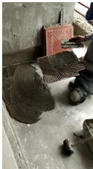
(c) Sulcos executados sem ordem específica
