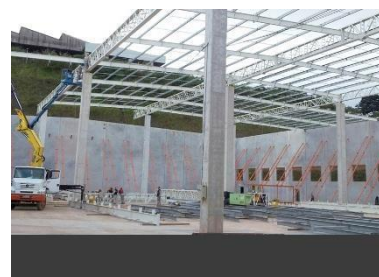
Escoramento e montagem da cobertura
