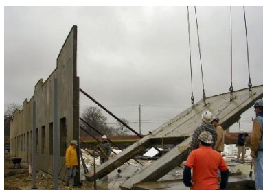
Içamento e levantamento dos painéis
