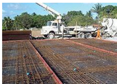
Distribuição de armaduras
