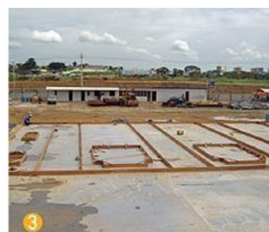
Montagem das fôrmas dos painéis
