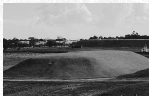
Rejeitos Radioativos em Abadia de Goiás na CNEN Fonte: https://www.em.com.br/app/noticia/nacional/2023/07/17/interna_nacional,1520762/cesio-137-cnem-ainda-monitora-cemiterio-de-rejeitos-em-goias.shtml
