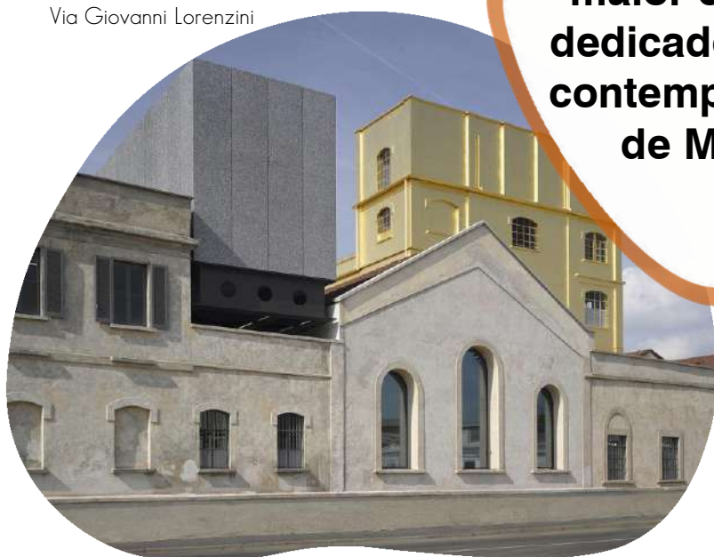
Figura 50 - Fachada norte da Fundação localizada na Via Giovanni Lorenzini
